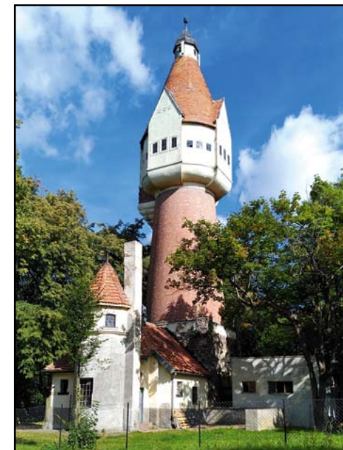
Wieża ciśnień w Pasymiu z 1911 r. z przybudówką, w której niegdyś mieściła się łaźnia miejska
