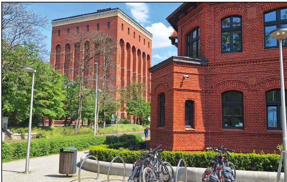
Wieża ciśnien w Wrocławiu wybudowana w latach 1866–1871. Jeden z najstarszych obiektów technicznej infrastruktury miasta
