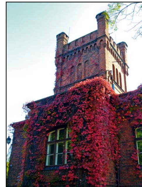
Dawna wieża wodna zasilająca wodociąg miasta w Skierniewicach, obecnie Instytut Warzywnictwa
