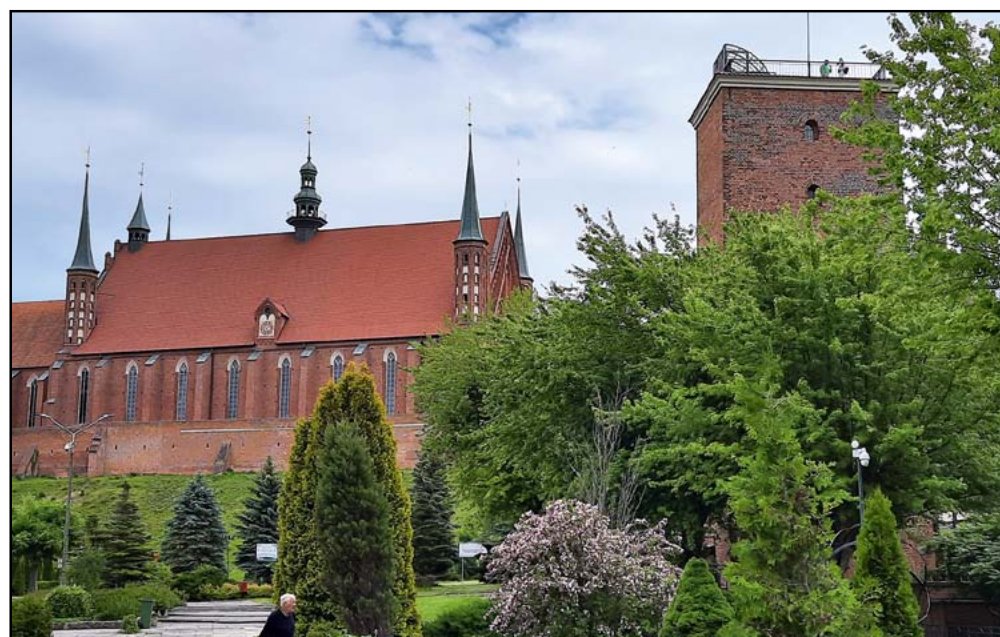
Wieża Wodna z 1571 r. we Fromborku. Dzięki zainstalowaniu nowoczesnego urządzenia czerpakowego woda rurami z pni sosnowych sphywała do katedry i domów kanoników na Wzgórzu Katedralnym. Obecnie służy jako wieża widokowa i kawiarnia
