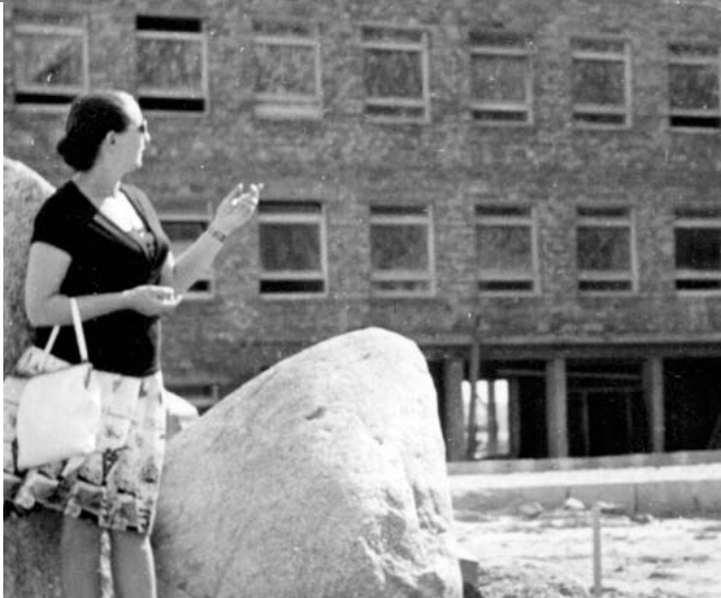
Rok 1962/1963. Nowy szpital przy ul. Żołnierskiej w Olsztynie w budowie
