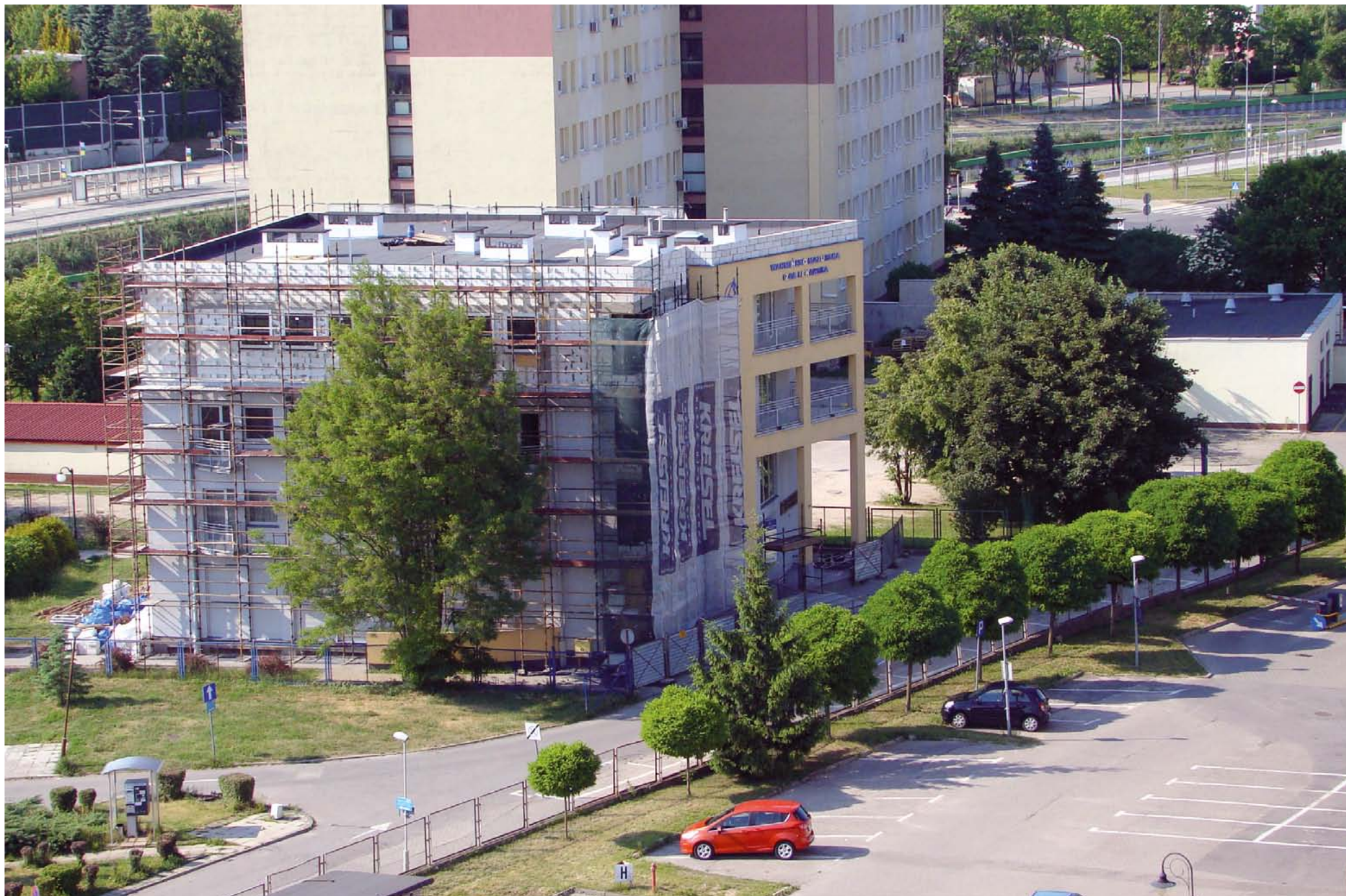
Rozbudowa Domu Lekarza trwa. To przyszła nowoczesna baza stwarzająca warunki dla rozwoju zawodowego członków Izby
