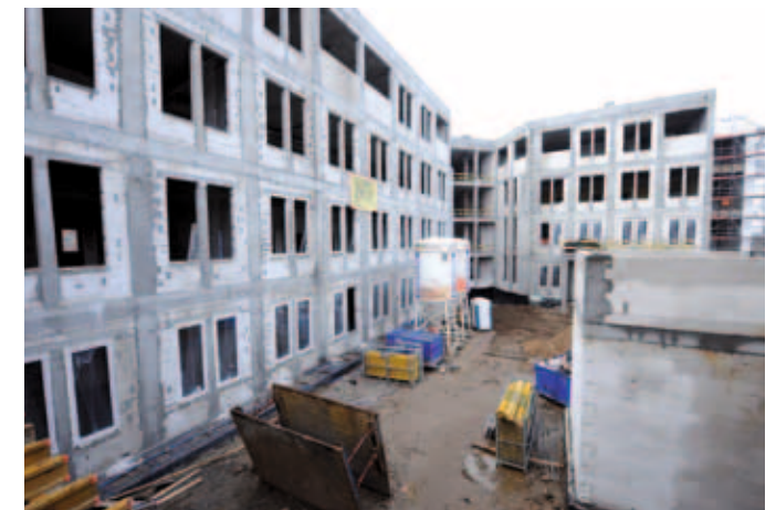
Budowa szpitala – Kampus Warszawska 31
